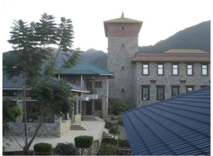
Library compound seen from the second floor Khuôn viên Thư Viện nhìn từ lầu hai
